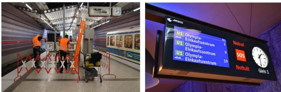
Im U2-Bahnhof Harthof wurden die letzten Fallblattanzeiger durch moderne Geräte ersetzt (links); ein neuer Anzeiger im U-Bahnhof Westfriedhof (rechts).
