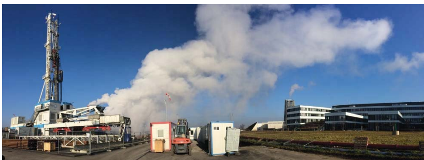
Pumpversuche an der ersten Bohrung im Dezember 2015 (Foto: SWM)
