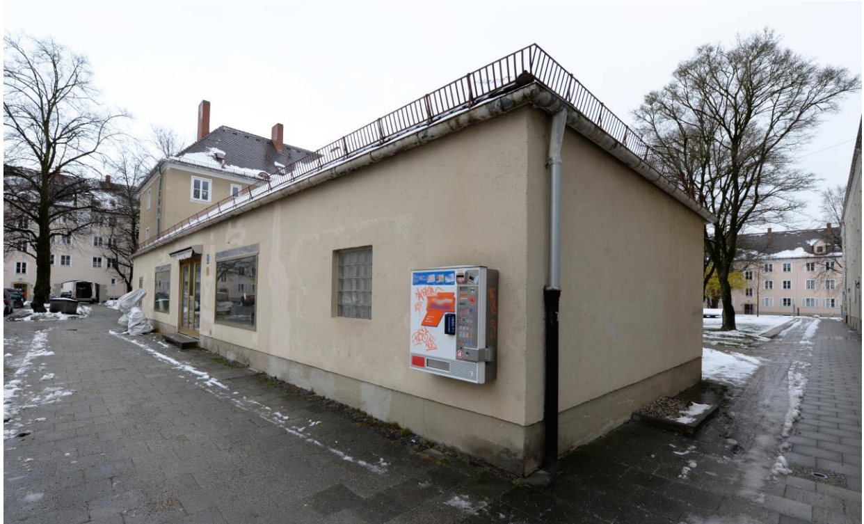
Ansicht Bestandsgebäude (Foto: GEWOFAG)
