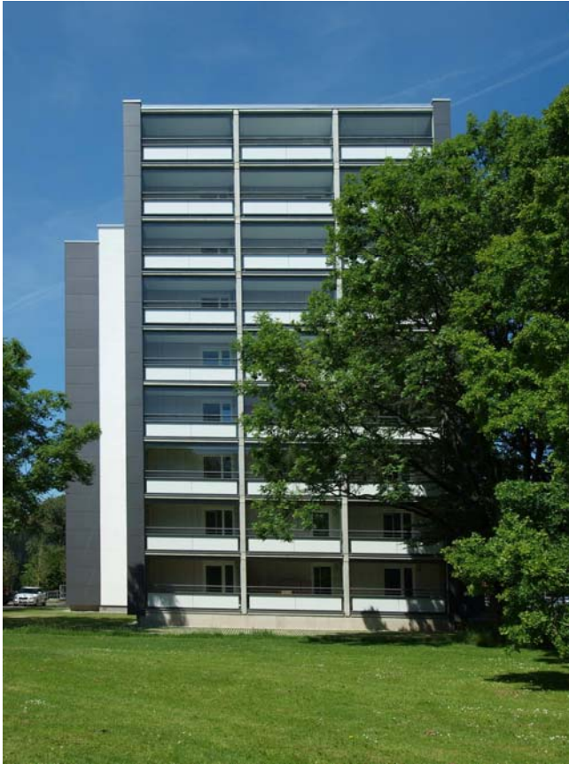
Fassade Pertisastraße 7 (Foto: Roland Weegen)
