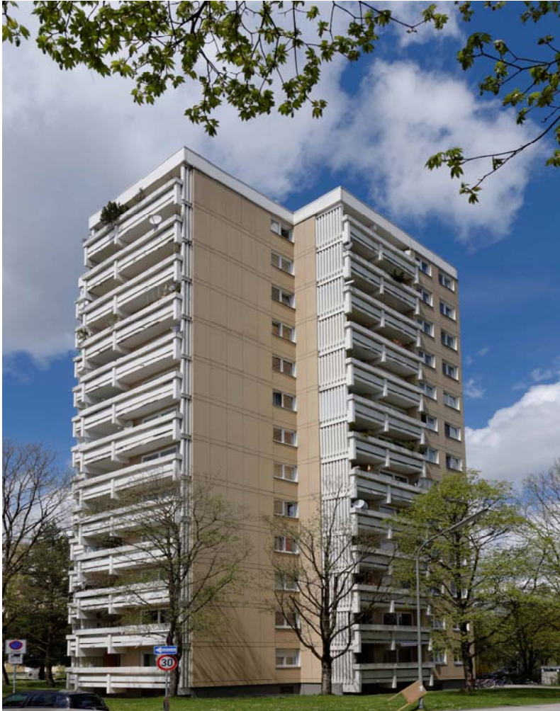
Das GEWOFAG-Gebäude am Ahornring 2 vor dem Abbruch der Balkone. (Foto: Roland Weegen.)
