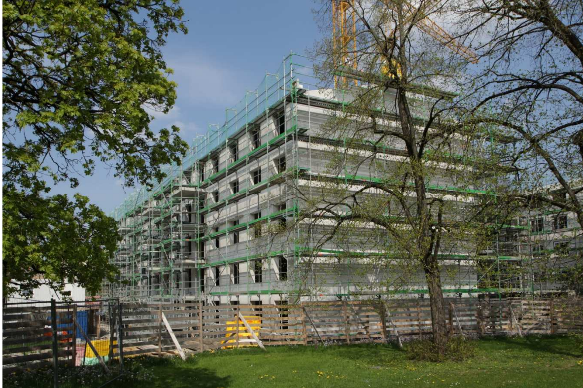
Außenansicht Minimalprojekt Hinterbärenbadstraße (Baustelle)
