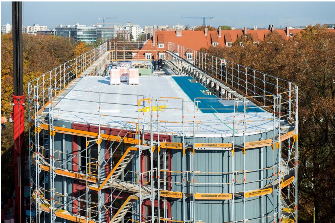
Das Bauvorhaben der GEWOFAG am Dantebad von oben (Foto: Lukas Barth).
