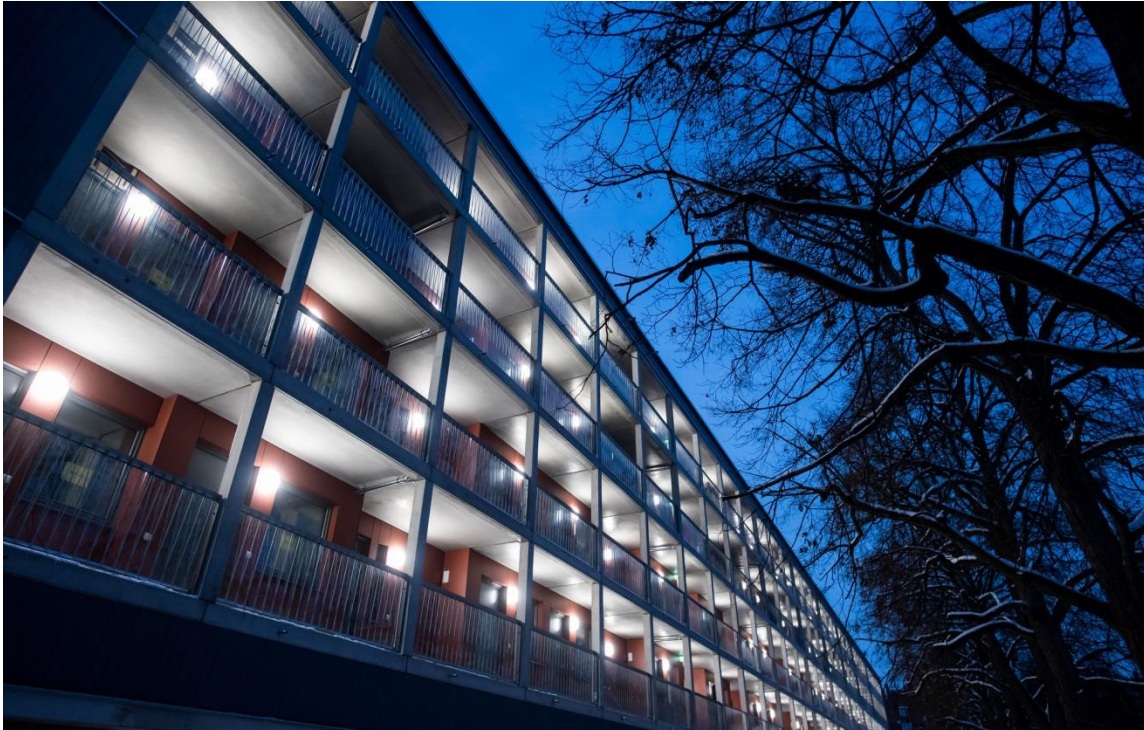
Pilotprojekt mit Breitenwirkung: Parkplatzüberbauung am Dantebad (Foto: Lukas Barth)
