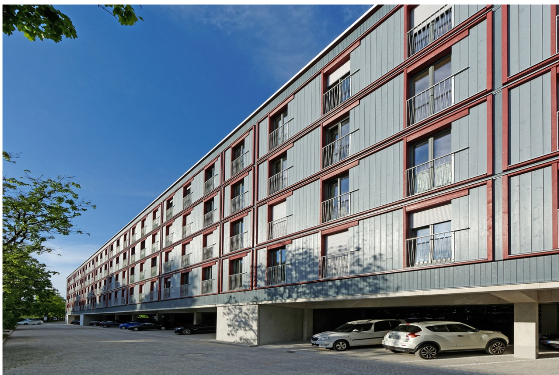
Ein Großteil der Parkplätze ist weiterhin nutzbar. (Foto: Roland Weegen).
