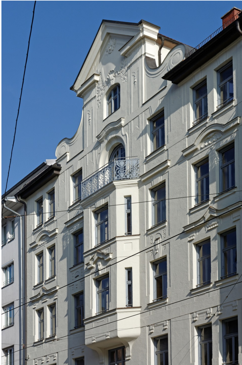
Die Fassade des Gebäudes Ismaninger Straße 4 nach der Sanierung (Foto: Roland Weegen).
