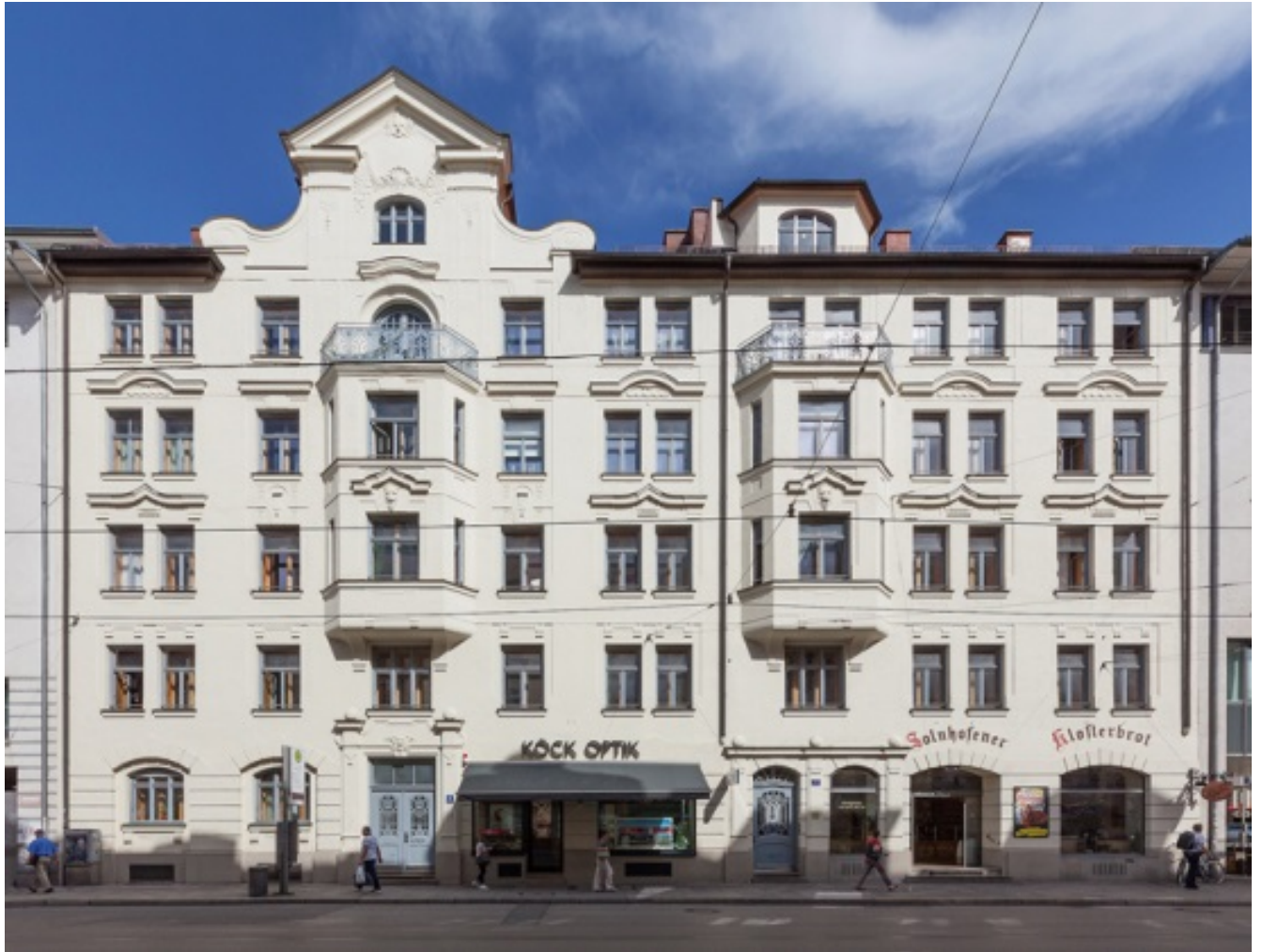
Die Fassade der Gebäude Ismaninger Straße 2 und 4 nach der Sanierung in der Gesamtansicht (Foto: maurer und sigl).
