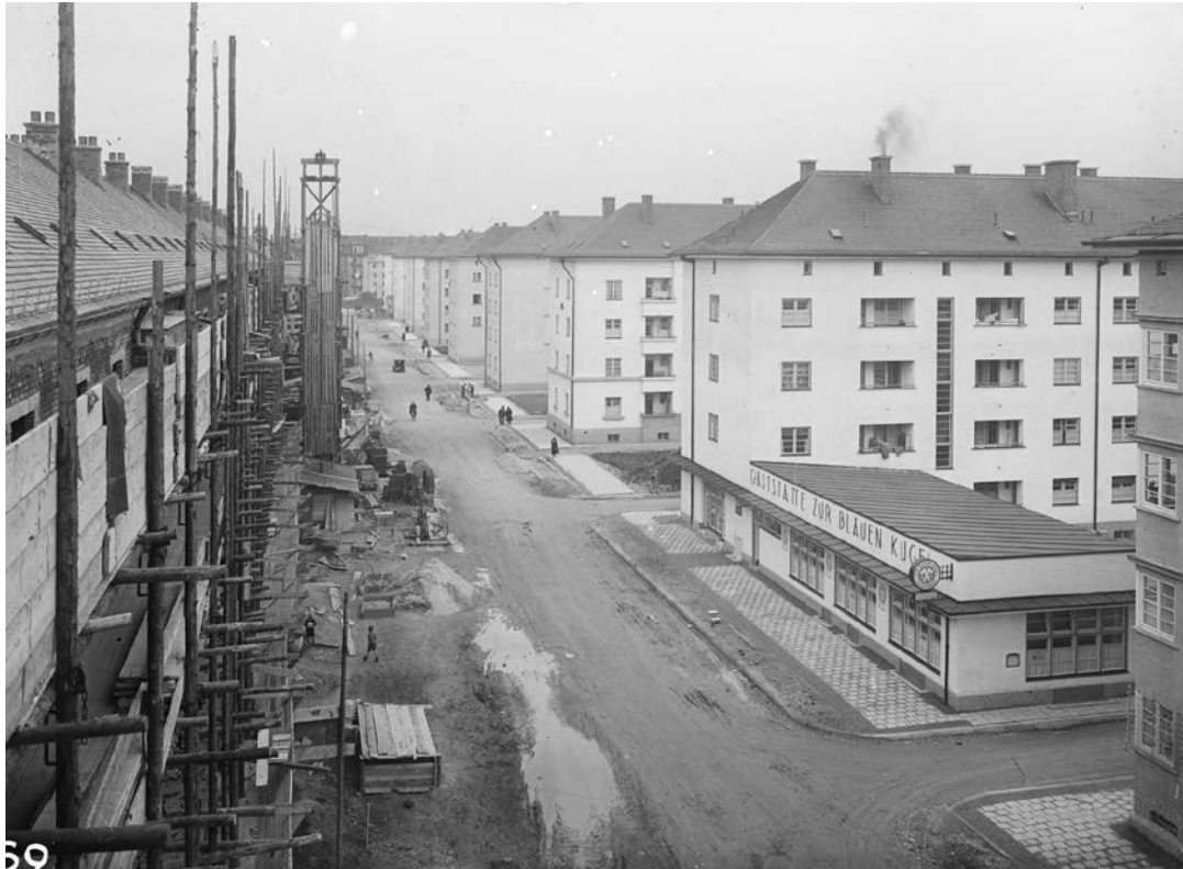
59 Baustelle der Siedlung Neuhausen um 1930 (Foto: GEWOFAG)
