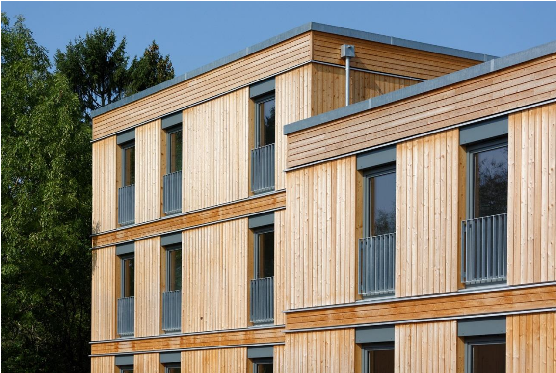
Die Holzfassaden der neuen GEWOFAG-Gebäude an der Schittgablerstraße (Foto: Roland Weegen)
