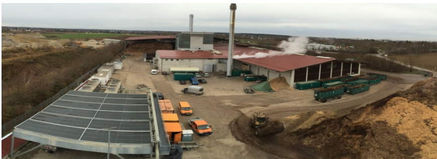
BioEnergie Taufkirchen: Panoramaansicht der Anlage.
