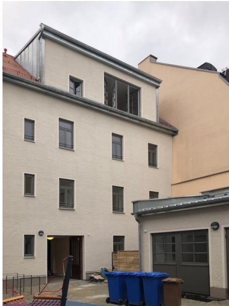
Der Innenhof nach der Sanierung
