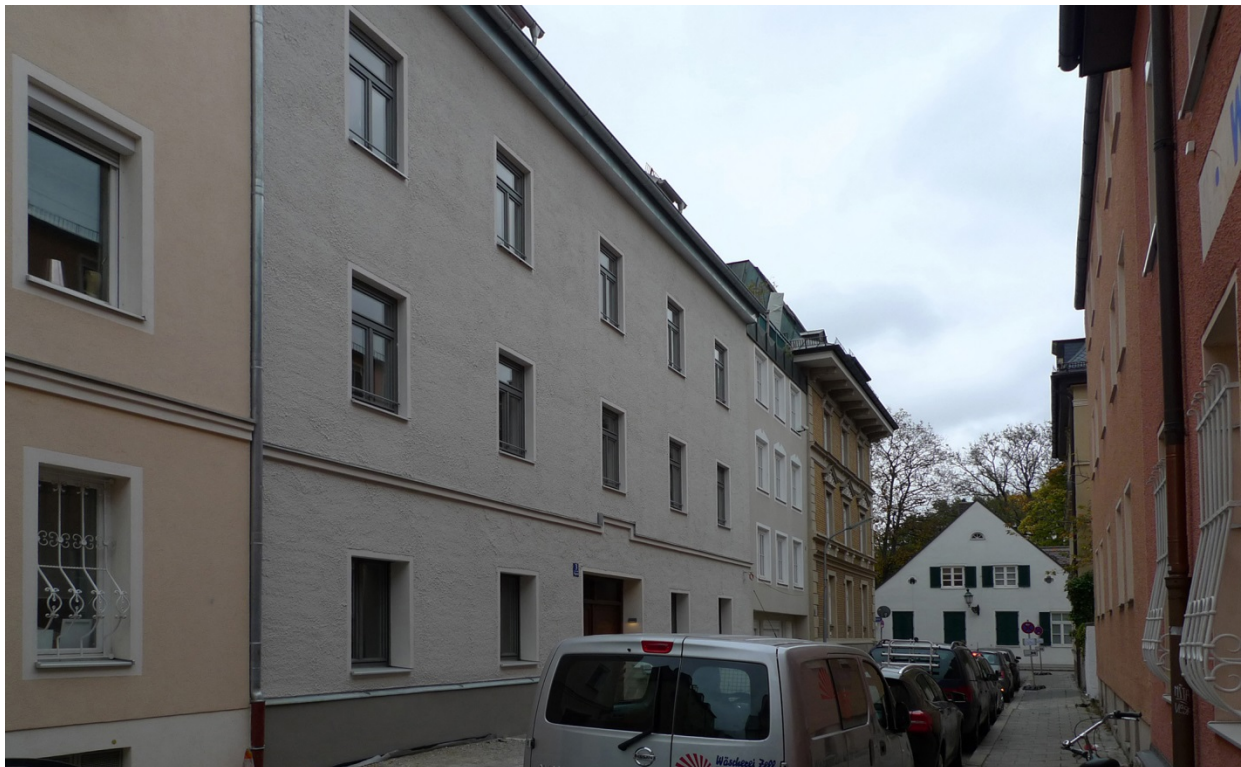
Das Gebäude Wagnerstraße 3 nach der Sanierung (Foto: Zwischenräume Architekten + Stadtplaner, München)
