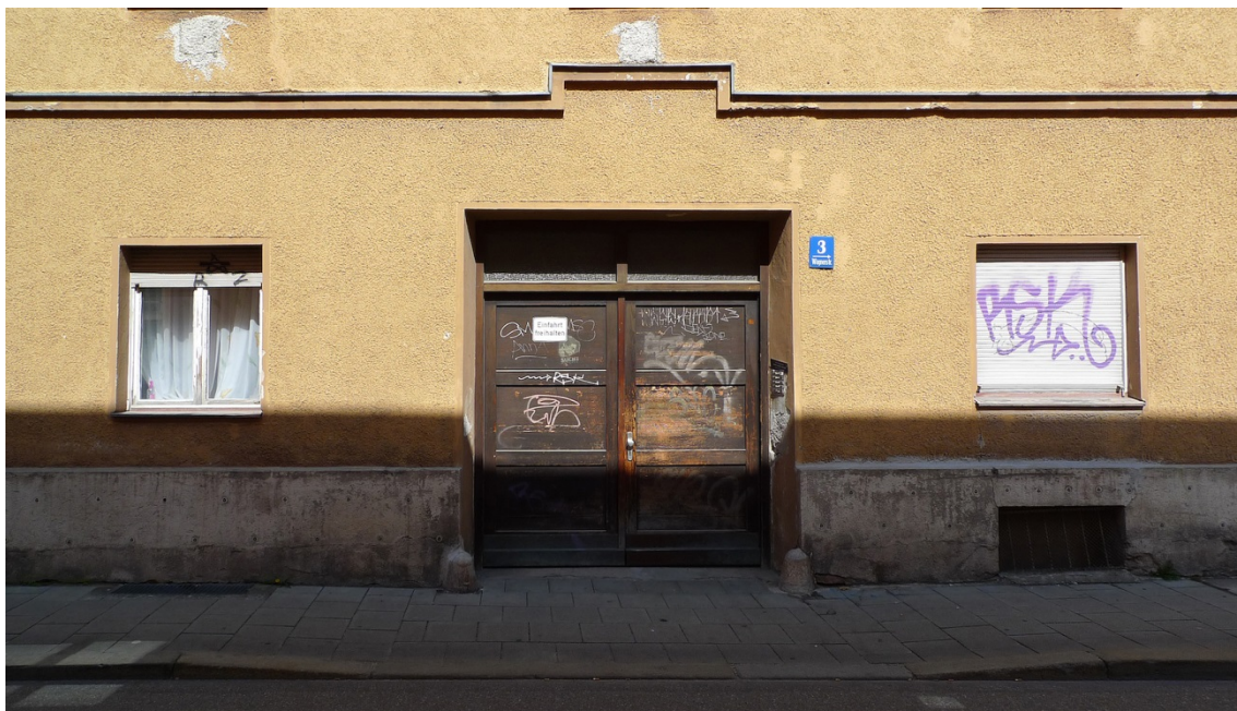
Der Eingangsbereich vor der Sanierung
