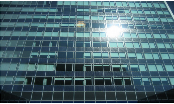
Solarfassade Verwaltungsgebäude Utrecht
