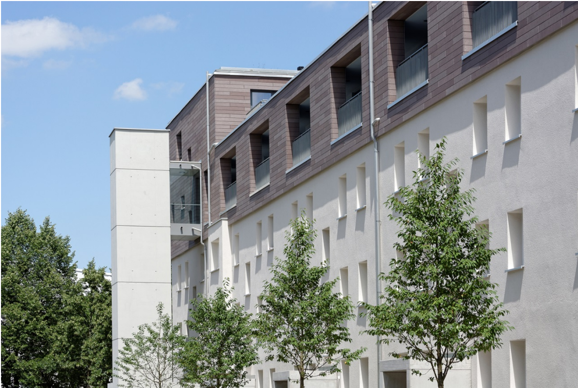
Die Gebäudeaufstockung in der Siedlung Sendling (Foto: Roland Weegen)
