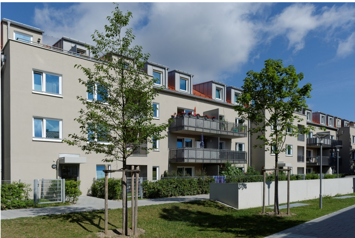
GEWOFAG-Neubau an der Passauerstraße (Foto: Roland Weegen)
