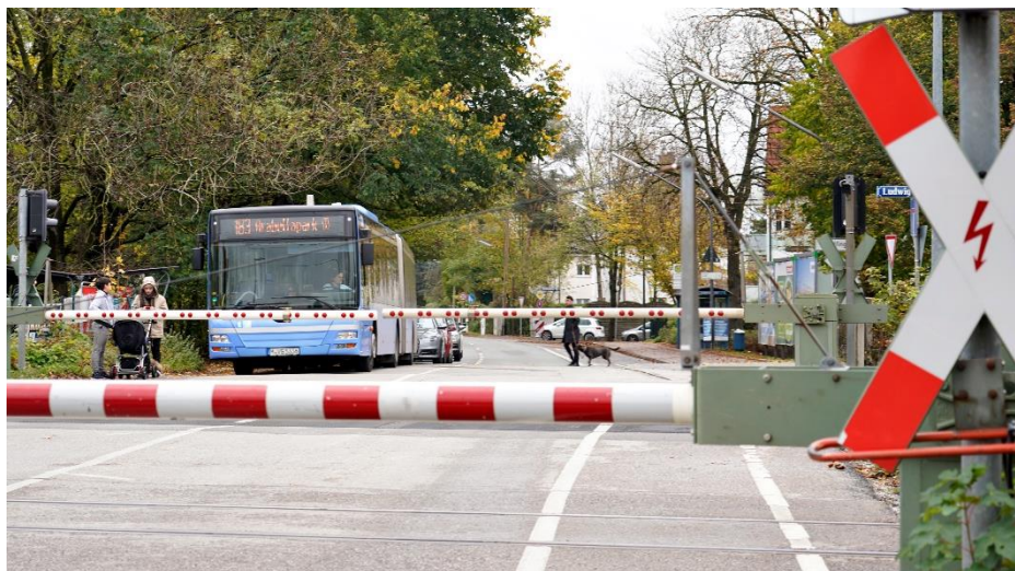
Thomas Höhler: Beispiel Bahnschranke Daglfing: Hier ist keine Absicherung mit einem Gitterbehäng vorhanden.
