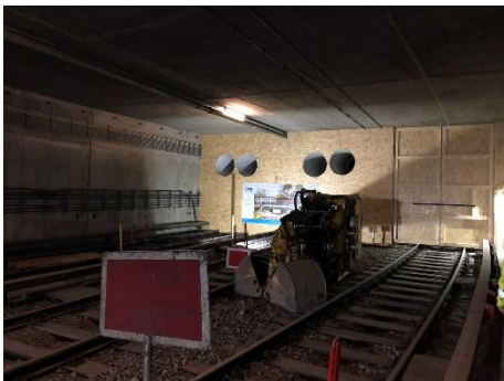
Das Weichenfeld nördlich des U-Bahnhofs Implerstraße: Eine Bewetterungsanlage sorgte für die Belüftung und den Abtransport anfallenden Staubs (l.o. und l.u.). Neue Schienenteile werden im Thermitschweißverfahren miteinander verbunden (r.)
