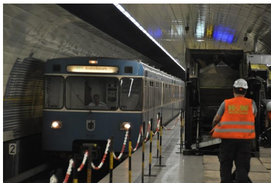
Während des Umbaus war kein Fahrgastwechsel möglich – der Bahnsteig wurde als Lagerfläche benötigt
