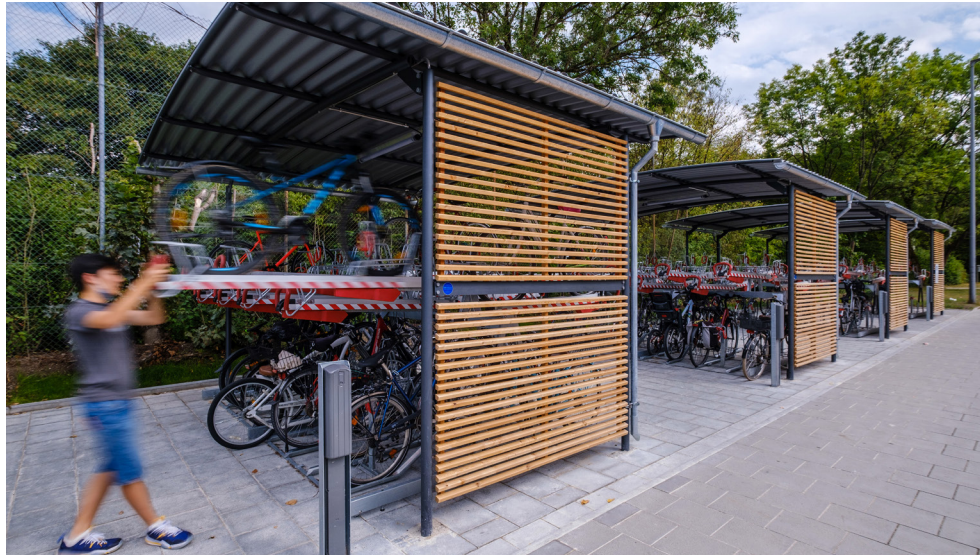
Die neue Fahrradabstellanlage an der U-Bahn-Station Quiddestraße bietet Platz für annähernd 150 Räder. (Foto: Peter Schinzler)
