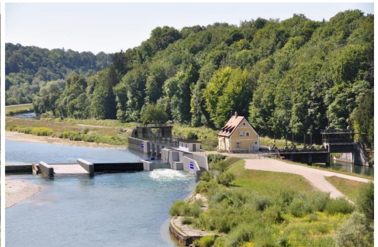
Links das Großhesseloher Wehr – rechts die Anlage nach dem Umbau mit der Fischtreppe. Visualisierungen: cam.p-solutions
