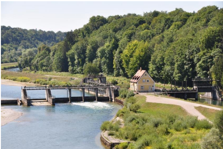
Links das Großhesseloher Wehr – rechts die Anlage nach dem Umbau mit der Fischtreppe. Visualisierungen: cam.p-solutions
