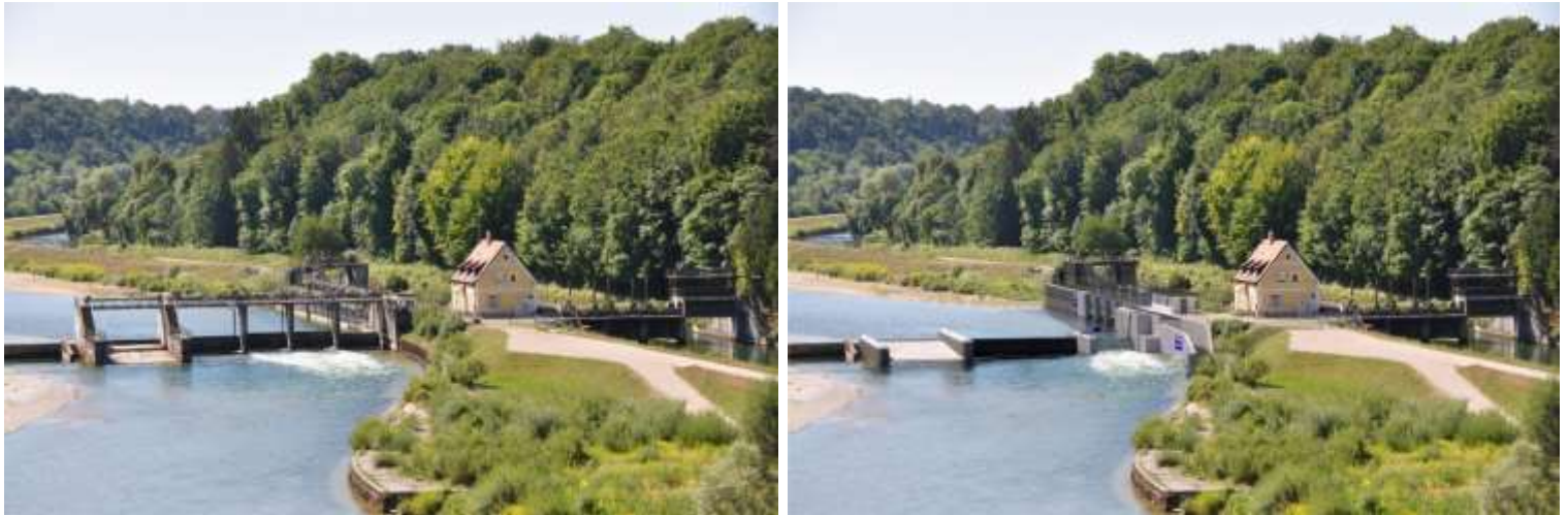
Links das Großhesseloher Wehr – rechts die Anlage nach dem Umbau mit der Fischstufe. Visualisierungen: cam.p-solutions
