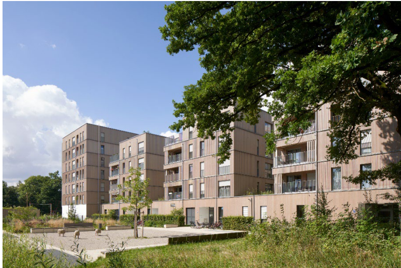
Prinz Eugen Park, Jörg-Hube-Straße - Holzhybridbauweise
