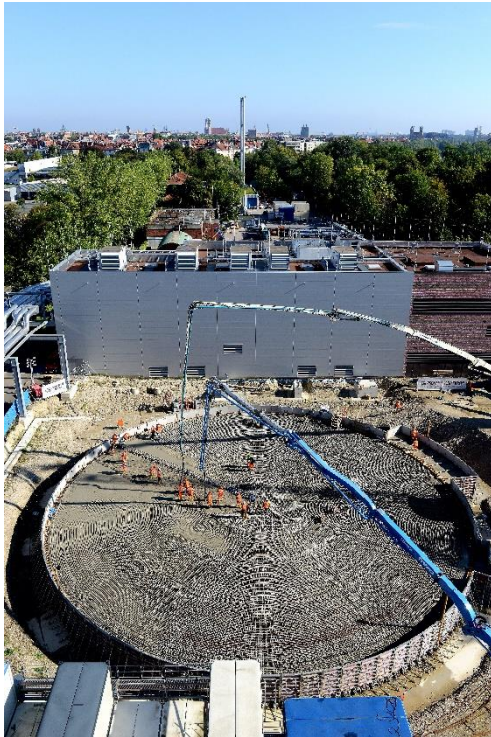
18 Stunden lang dauerte das Betonieren des Fundaments für den Wärmespeicher am Energiestandort Süd. Fotos: SWM
