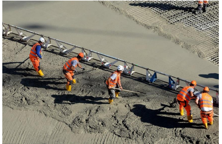
18 Stunden lang dauerte das Betonieren des Fundaments für den Wärmespeicher am Energiestandort Süd. Fotos: SWM
