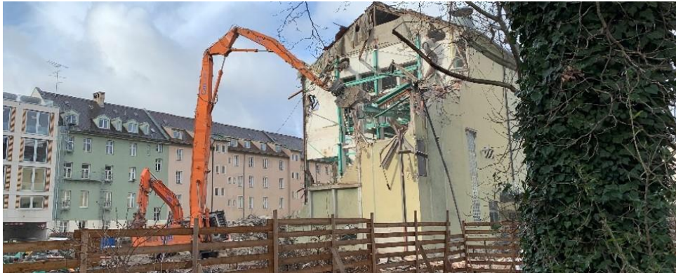
Rückblick auf die Baustelle: Abrissarbeiten auf der Baustelle an der Katharina-von-Bora-Straße. Foto: SWM
