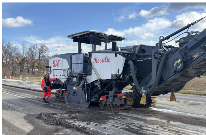
Die Maschinen rollen an: Baubeginn an der Wolfratshauer Straße (Foto: Baureferat)
