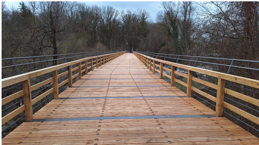
Der fertig sanierte Flauchersteg (Foto: Baureferat)
