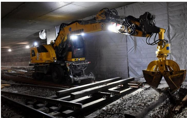
Ein Zwei-Wege-Bagger entfernt alte Weichen, Gleise und Schwellen.
