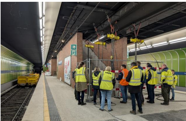
Projektleiter Elias Habersetzer erklärt die Erneuerung der Rolltreppen am Partnachplatz.
