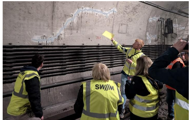
Projektleiter Hannes Vennekaas zeigt den Fortschritt der Tunnelsanierung.
