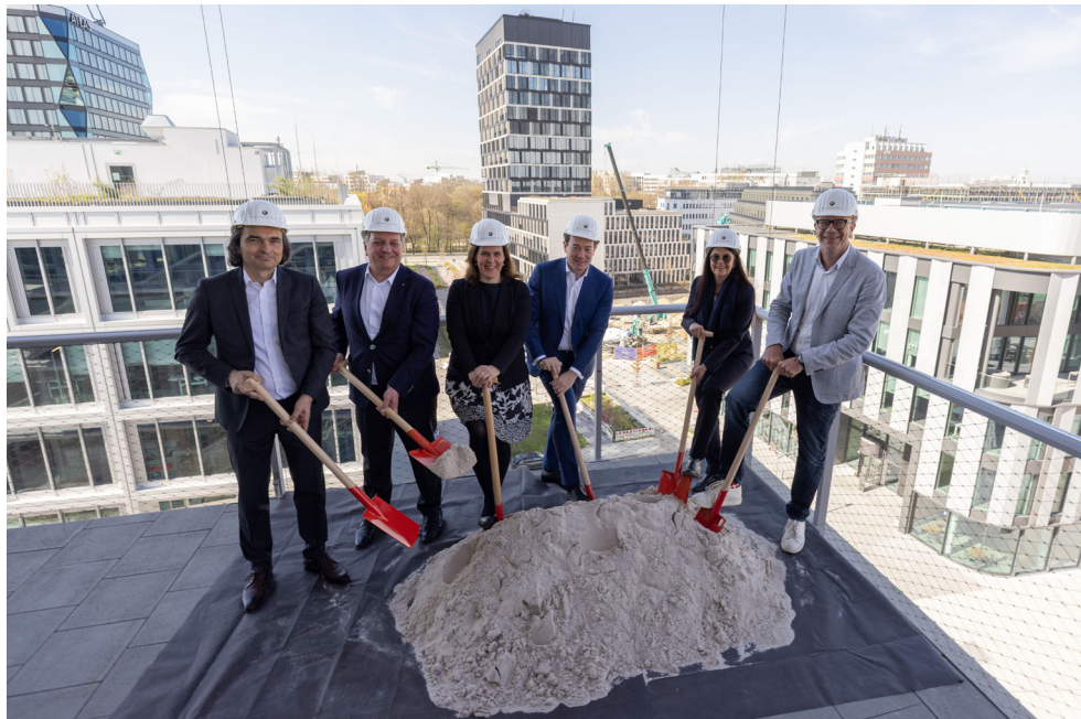
Spatenstich für Bürogebäude MONACO v.l.n.r.: Peter G. Neumann (Geschäftsführender Gesellschafter der Rock Capital Group), Christian Bernreiter (Bayerischer Staatsminister für Wohnen, Bau und Verkehr), Bürgermeisterin Verena Dietl, Christian Lealahabumung (Geschäftsführender Gesellschafter der Rock Capital Group), Stadtbaurätin Professorin Dr. (Univ. Florenz) Elisabeth Merk und Sven Thorissen (Direktor des Studio DAS beim Architekturbüro MVRDV). Foto: Christopher König
