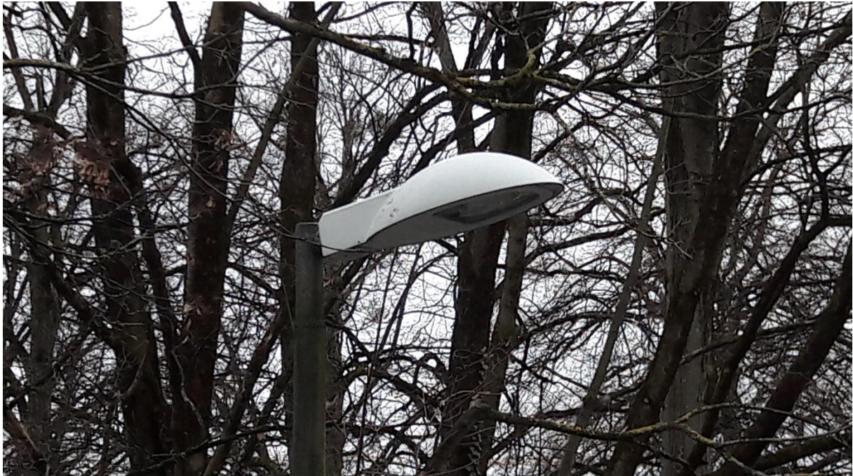
Foto (privat, zur Veröffentlichung freigegeben): Beispiel für eine Kofferleuchte, bei der die Lichtfarbe alle paar Jahre beim Leuchtmitteltausch wechselt.
