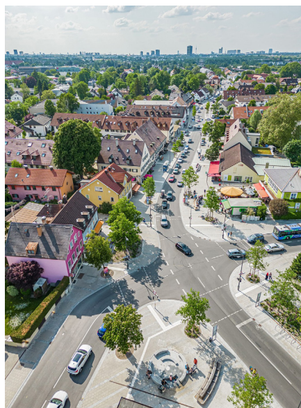
Der Umbau der Truderinger Straße ist mit dem „polis Award 2025“ ausgezeichnet worden (Foto: Boris Storz)
