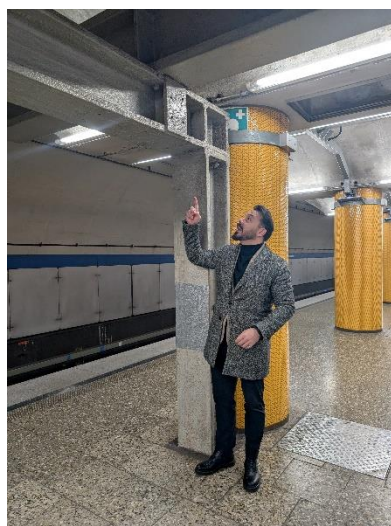
Projektleiter Mehmet Dönmez zeigt eine der bereits installierten Stahlunterstützungen am U-Bahnhof Poccistraße
