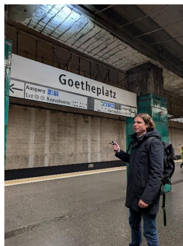
Projektleiter Philip Schmidt beleuchtet den zu sanierenden Unterzug am U-Bahnhof Goetheplatz.
