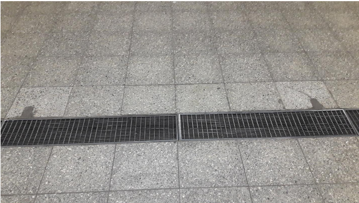
Foto (ÖDP): Fehlstelle demontierte Bank U-Bahn-Station Olympiazentrum
